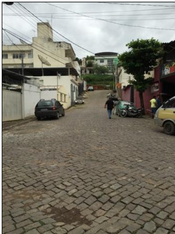
Figura 152 – Área Problema 4: região afetada pelo alagamento
