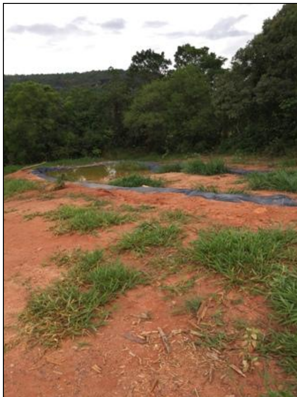
Figura 76 – Tanque de armazenamento de necrochorume
