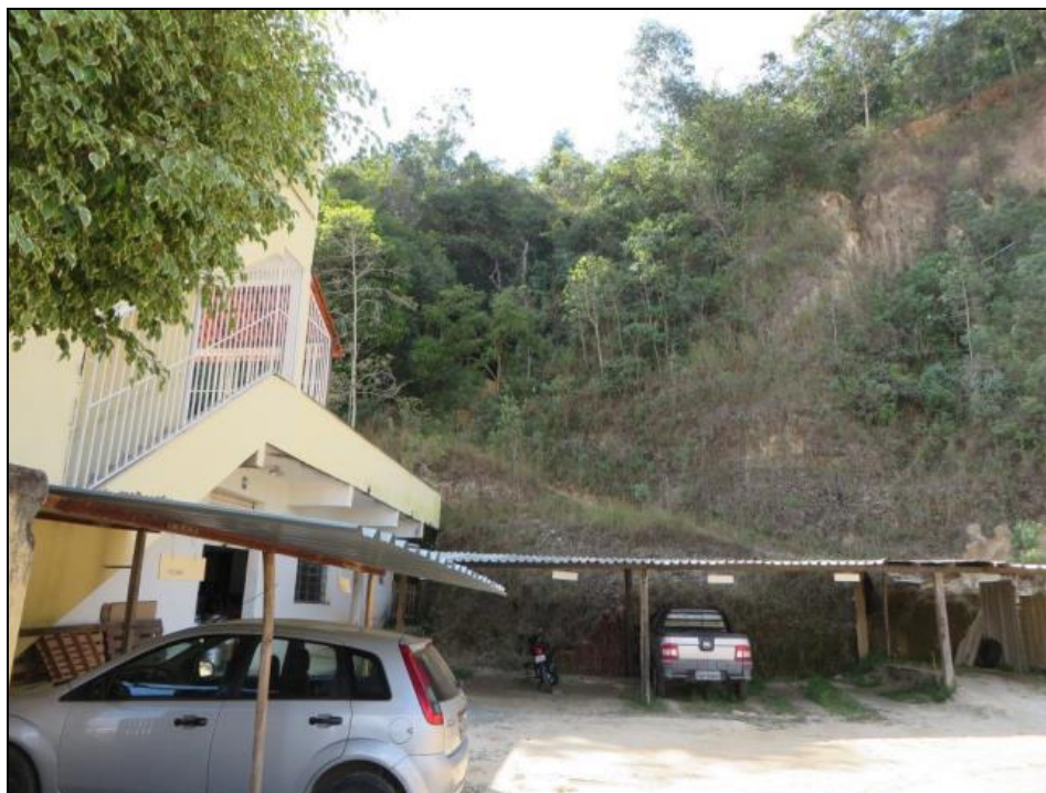
Figura 165 - Residência edificada na base de encosta com declividade acentuada Fonte: Ministério de Minas e Energia
