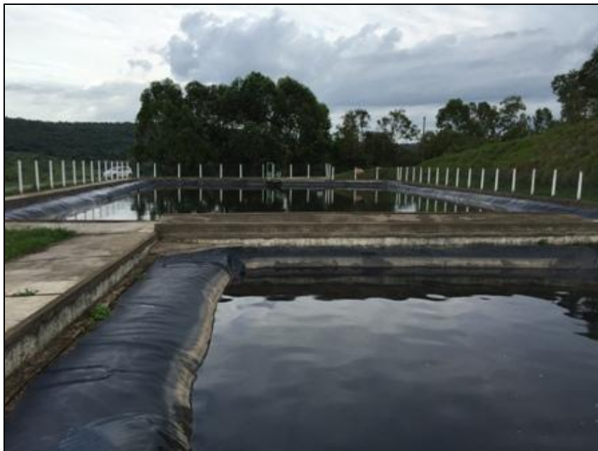
Figura 81 – Sistema de lagoas (tratamento do percolado)
