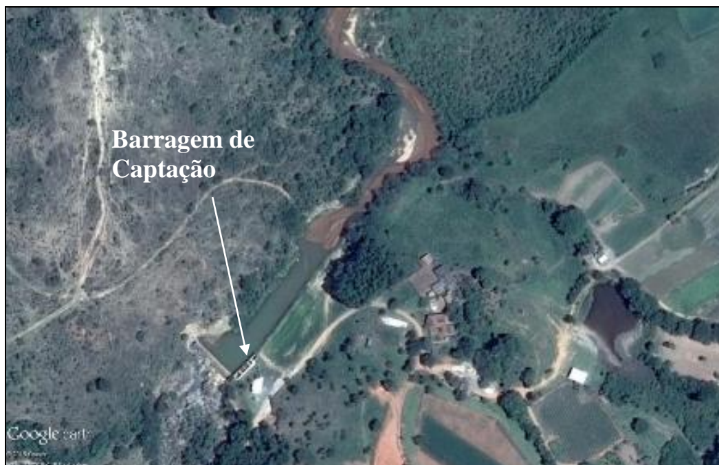
Figura 5 – Vista Superior da Barragem de Nível Rio Formiga
