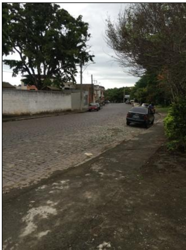
Figura 160 – Área Problema 8: região afetada pelo alagamento
