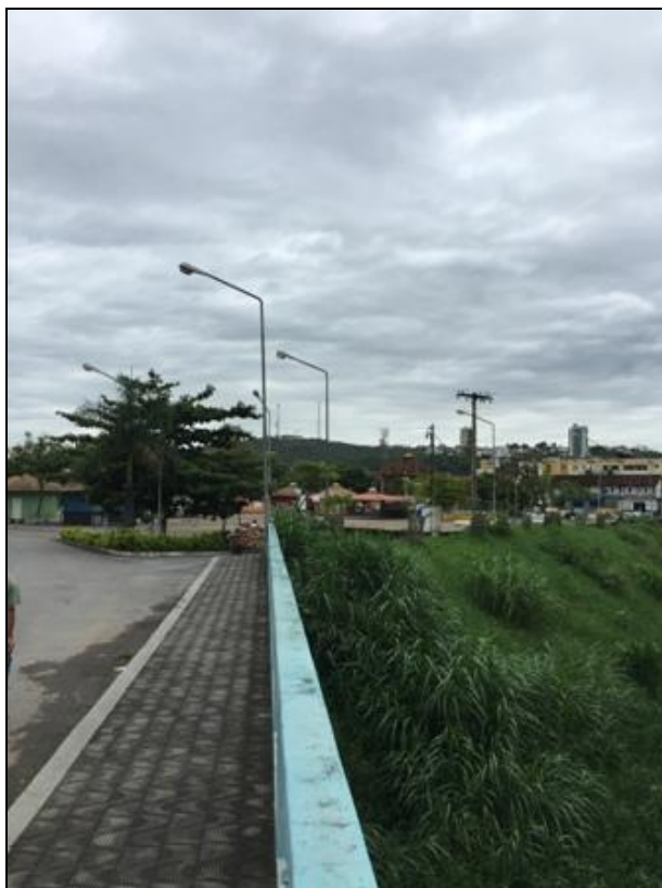
Figura 154 – Área Problema 5: região afetada pelo alagamento
