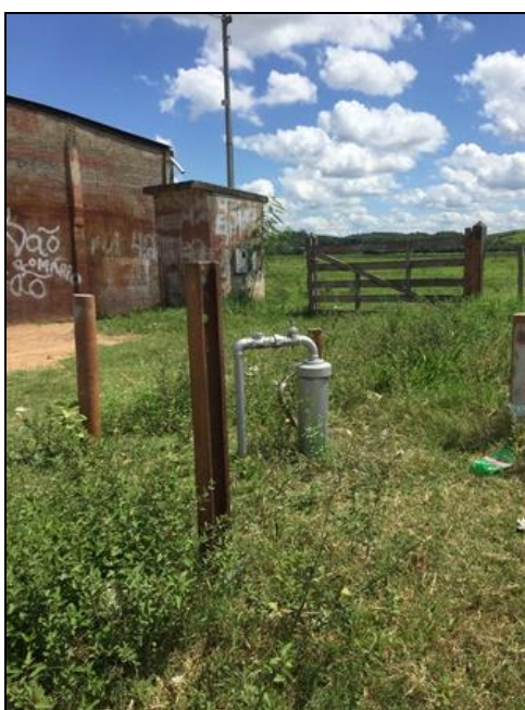
Figura 7 – Poço – Avenida Sebastião Jorge Lasmar
