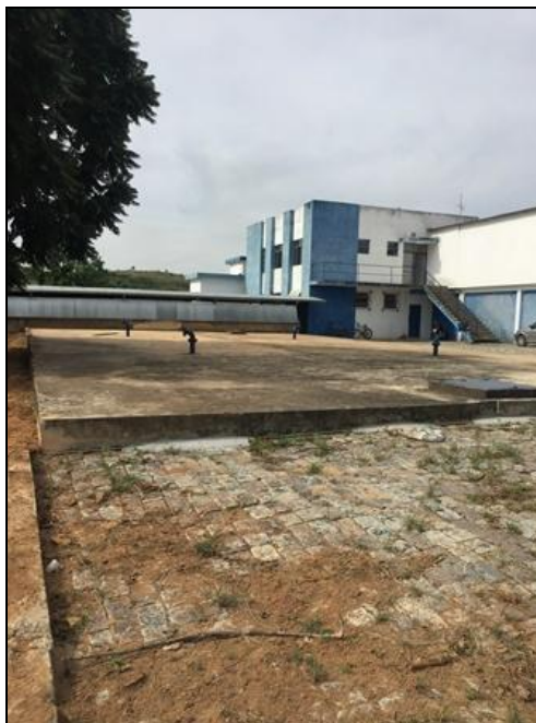
Figura 25 – Reservatório de Concreto – ETA
