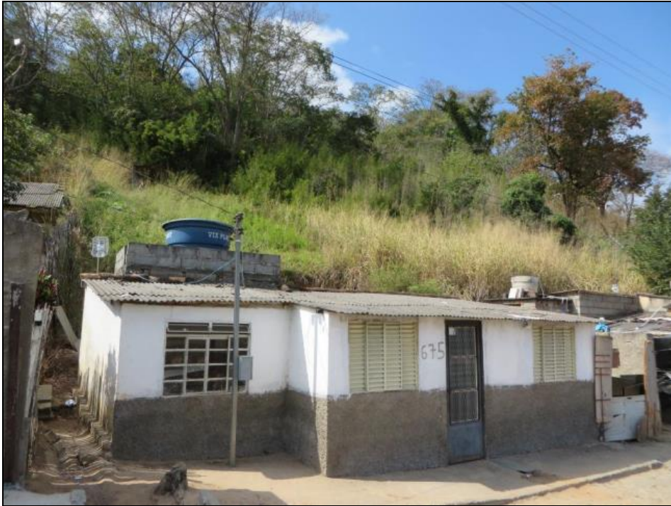
Figura 164 - Residência edificada na base de talude de corte verticalizado sem contenção Fonte: Ministério de Minas e Energia
