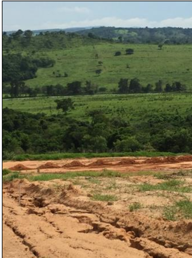
Figura 101 – Vista geral (Área 2)
