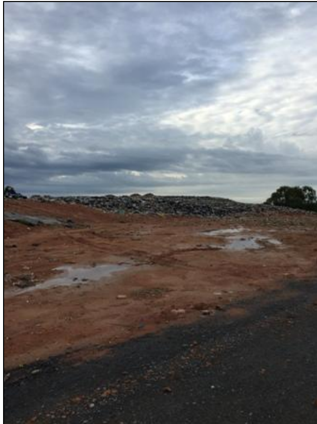
Figura 83 – Frente de trabalho do aterro sanitário
