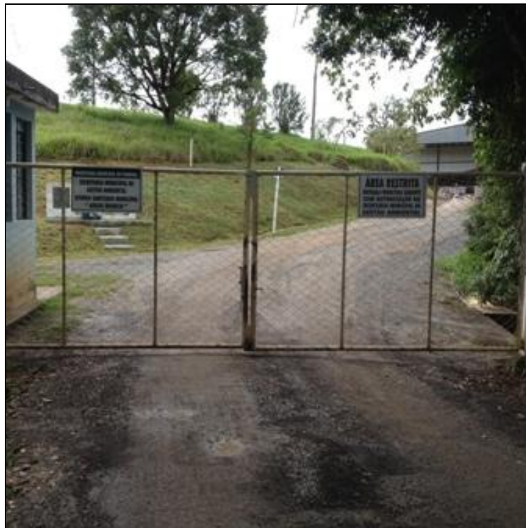
Figura 108 – Portão de entrada do aterro sanitário (vista externa)
