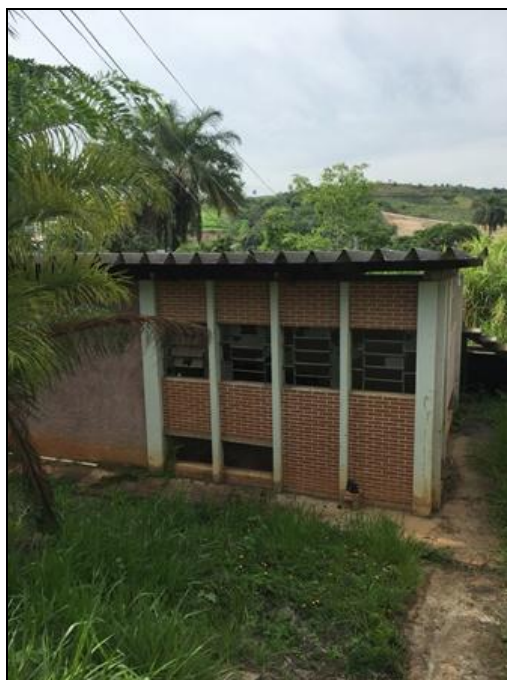
Figura 11 – Estação de Recalque de Água Bruta - ERAB
