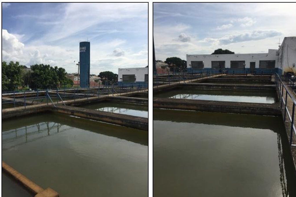
Figura 19 – Decantadores
