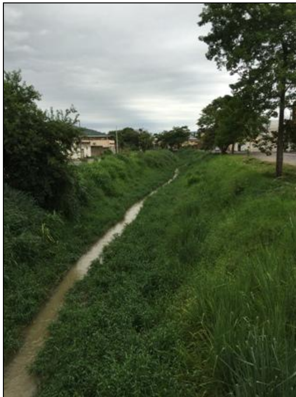
Figura 159 – Área Problema 8: Rio Mata Cavallo com excesso de vegetação
