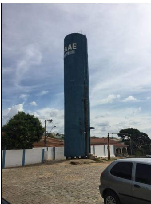
Figura 26 – Reservatório Metálico – ETA
