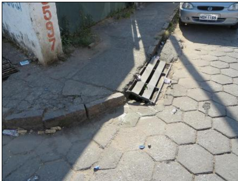
Figura 119 – Boca de lobo em Formiga (tipo 1)
