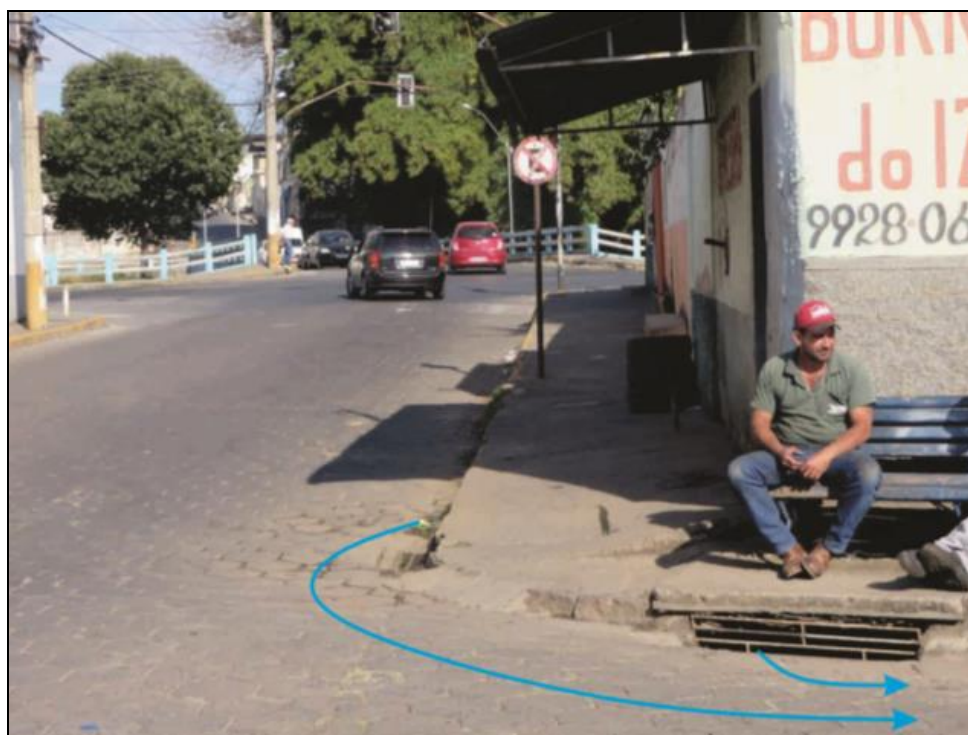
Figura 144 – Rua inundada pelo retorno da água do rio por meio do sistema de drenagem Fonte: Ministério de Minas e Energia
