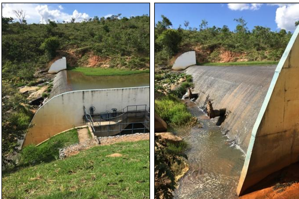
Figura 4 – Barragem de Nível Rio Formiga
