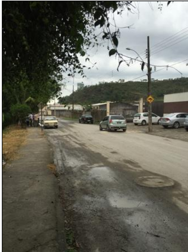
Figura 146 – Área Problema 1: avenida e arredores às margens do Rio Formiga
