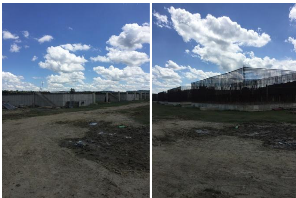
Figura 40 – Canteiro de Obras da ETE Formiga
