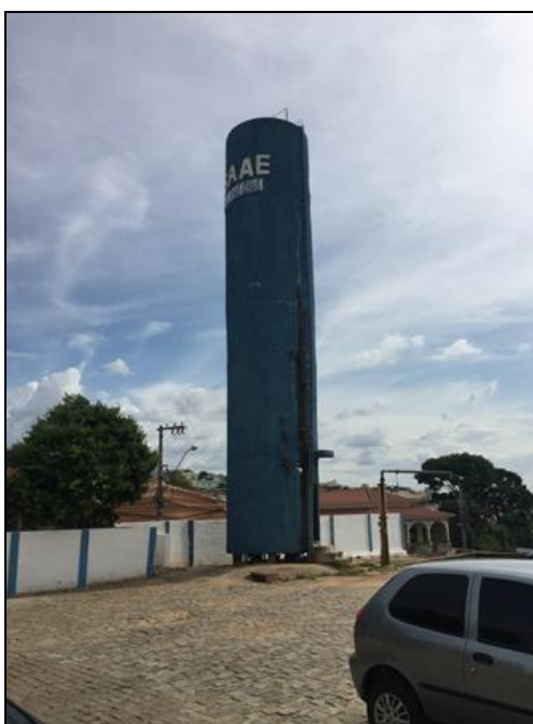
Figura 26 – Reservatório Metálico – ETA
