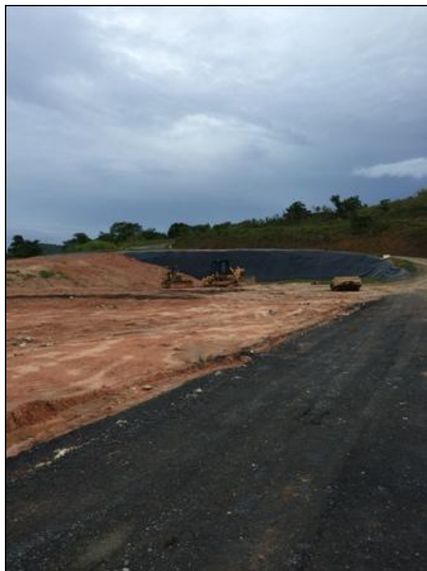
Figura 79 – Vista geral do aterro sanitário
