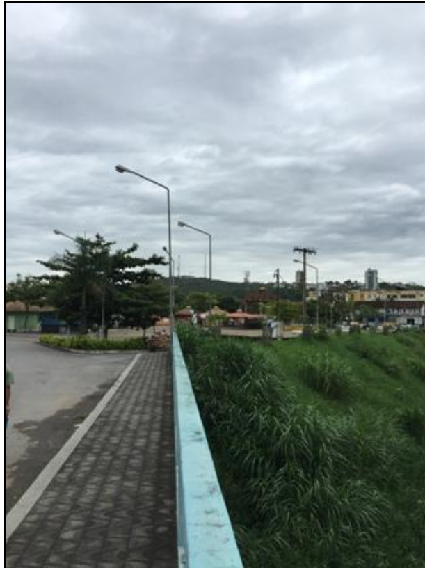
Figura 154 – Área Problema 5: região afetada pelo alagamento
