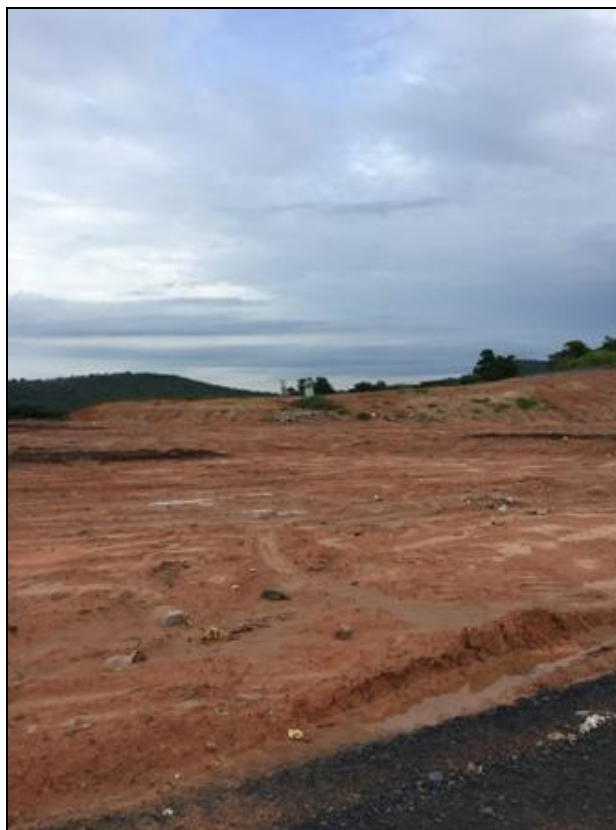
Figura 112 – Vista parcial do aterro
