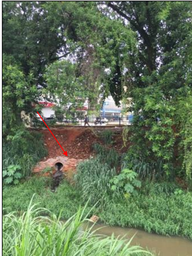
Figura 147 – Área Problema 2: bueiro contribuinte ao Rio Formiga
