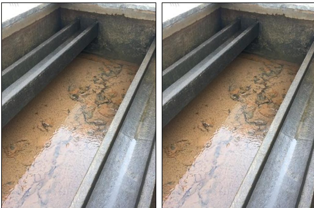
Figura 21 – Processo de Lavagem dos Filtros
