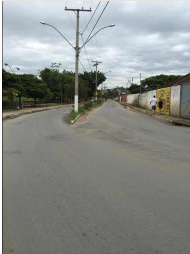
Figura 155 – Área Problema 6: região afetada pelo alagamento
