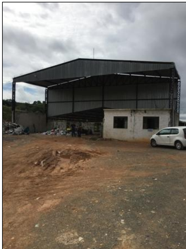
Figura 68 – Vista frontal do galpão de triagem
