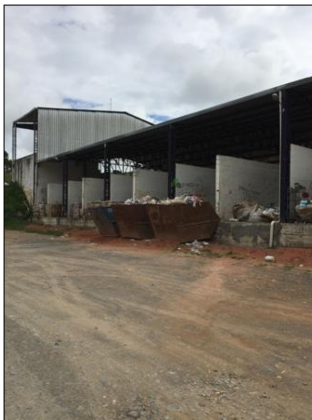
Figura 69 – Vista lateral do galpão de triagem
