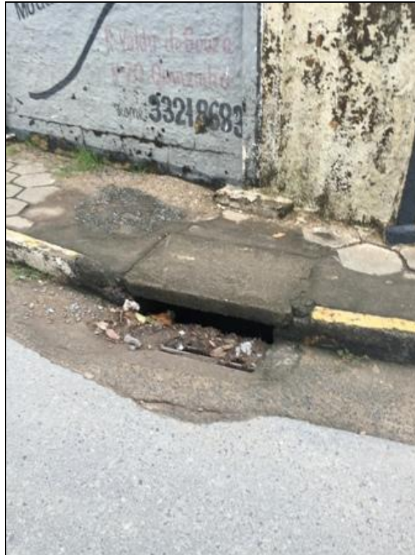
Figura 120 – Boca de lobo em Formiga (tipo 2)
