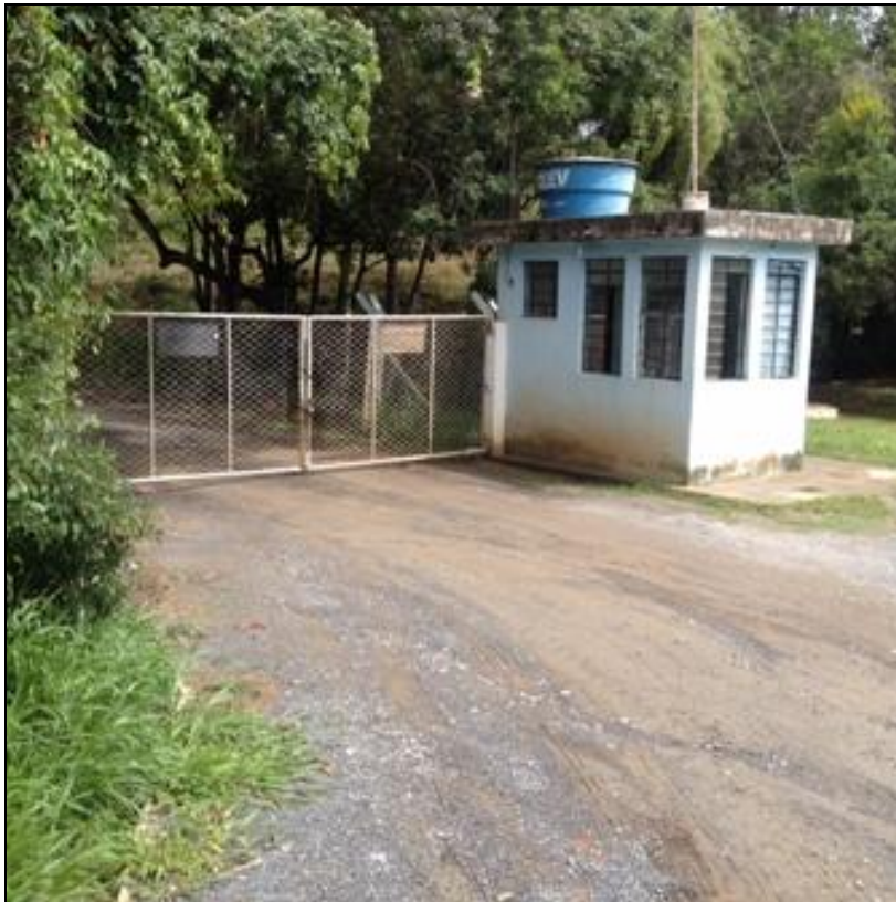
Figura 77 – Guarita e acesso ao aterro sanitário (vista interna)
