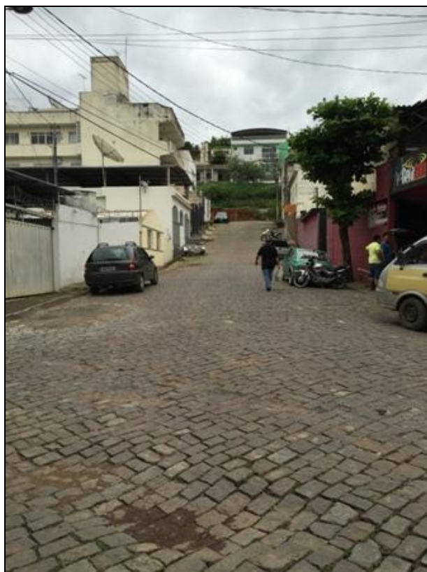
Figura 152 – Área Problema 4: região afetada pelo alagamento
