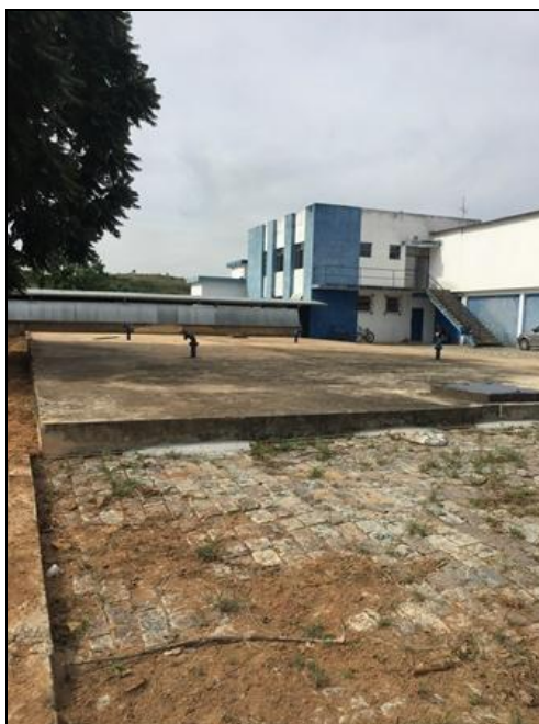
Figura 25 – Reservatório de Concreto – ETA
