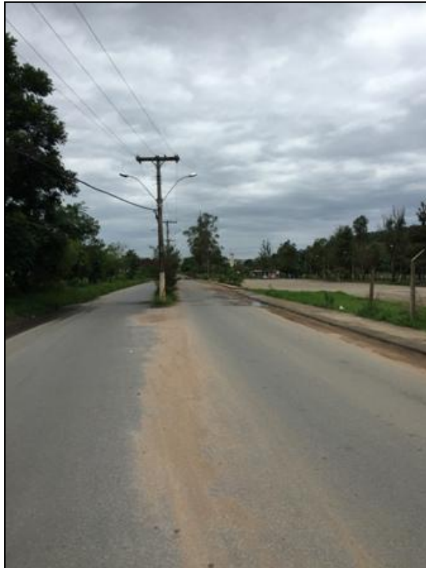
Figura 158 – Área Problema 7: região afetada pelo alagamento
