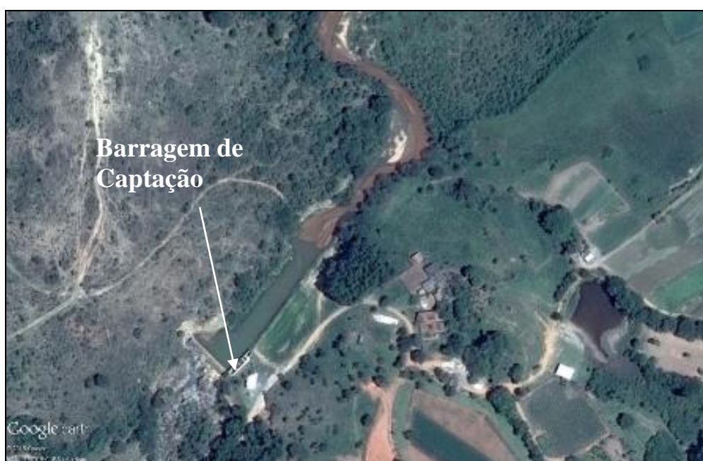
Figura 5 – Vista Superior da Barragem de Nível Rio Formiga
