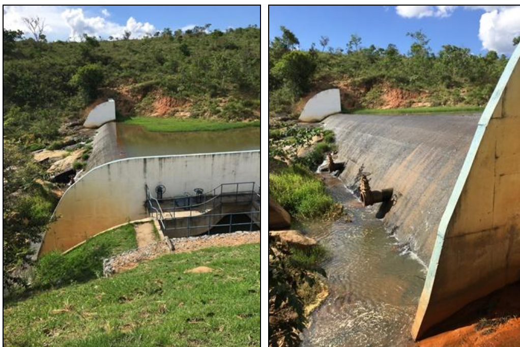
Figura 4 – Barragem de Nível Rio Formiga
