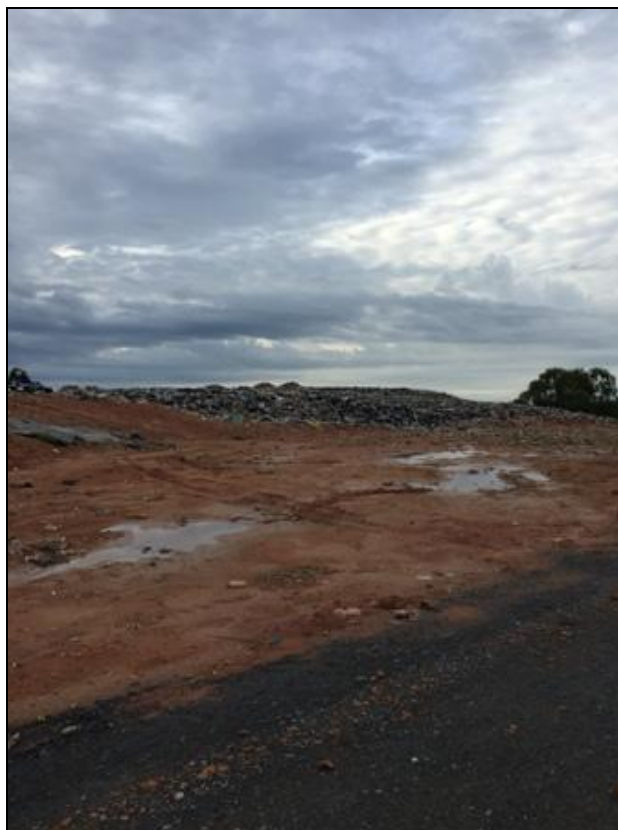
Figura 83 – Frente de trabalho do aterro sanitário
