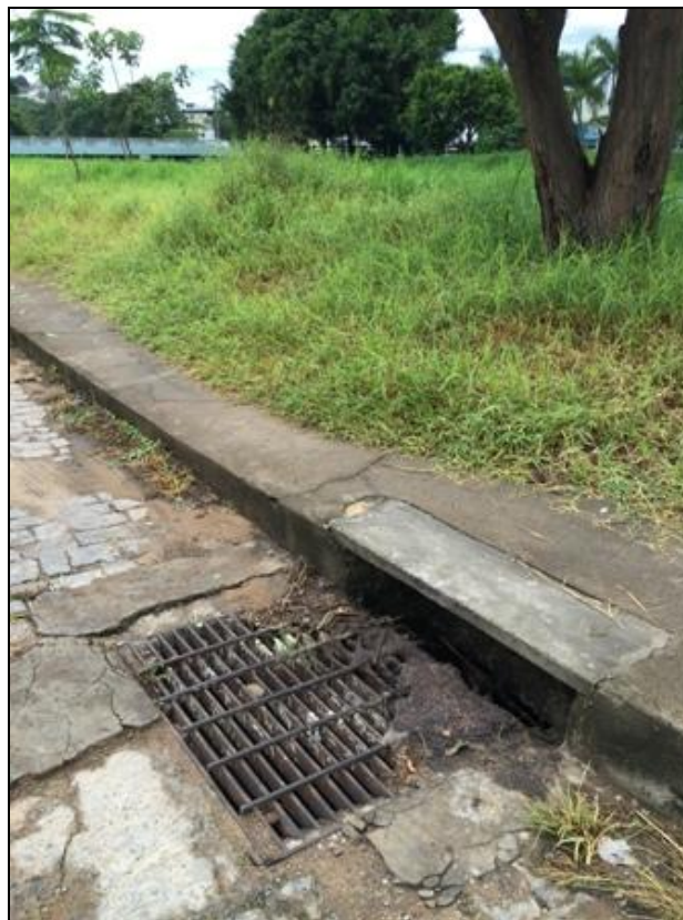
Figura 121 – Boca de lobo em Formiga (tipo 3)
