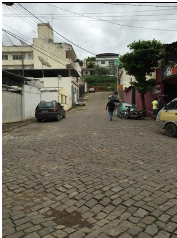
Figura 152 – Área Problema 4: região afetada pelo alagamento
