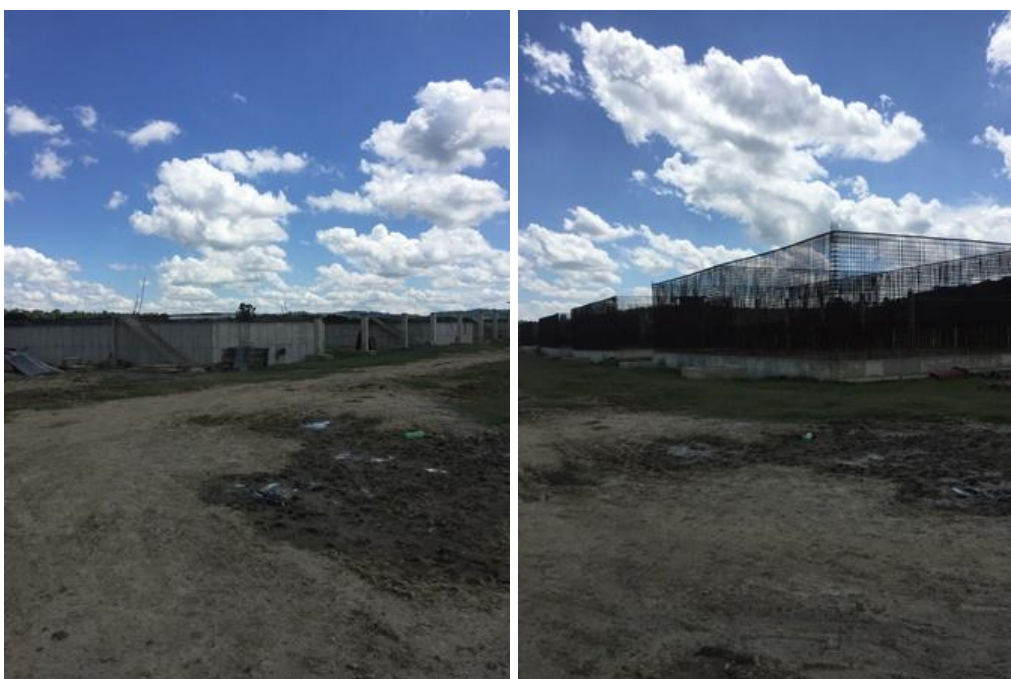
Figura 40 – Canteiro de Obras da ETE Formiga
