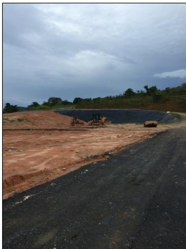
Figura 79 – Vista geral do aterro sanitário
