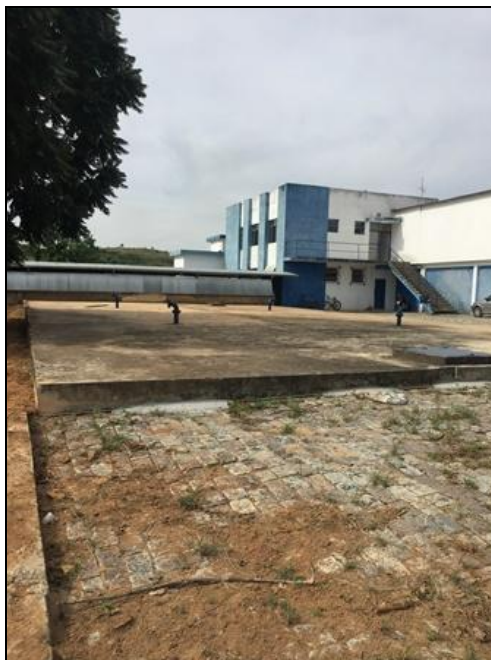
Figura 25 – Reservatório de Concreto – ETA
