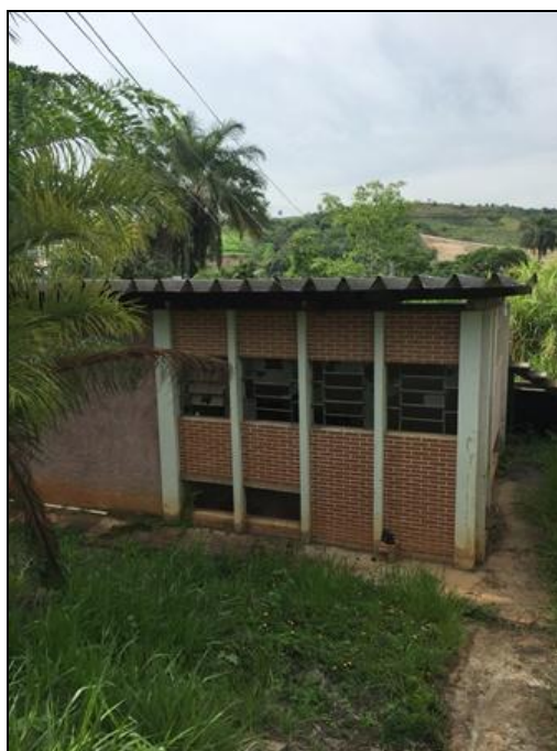
Figura 11 – Estação de Recalque de Água Bruta - ERAB
