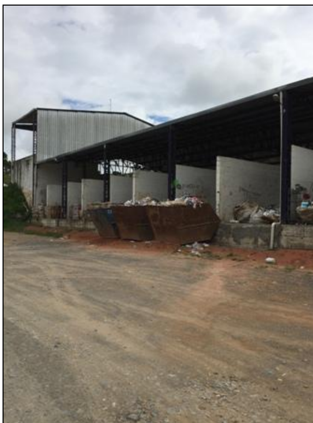
Figura 69 – Vista lateral do galpão de triagem
