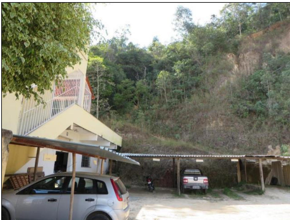
Figura 165 - Residência edificada na base de encosta com declividade acentuada Fonte: Ministério de Minas e Energia
