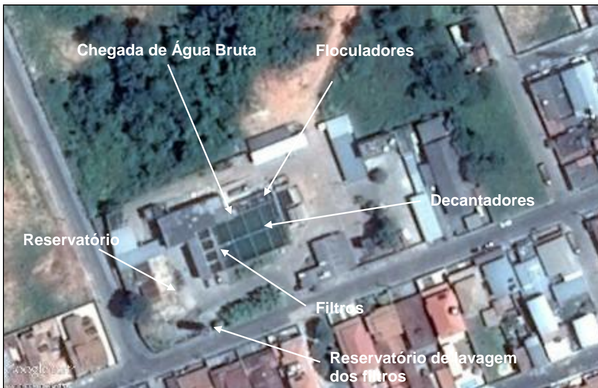
Figura 15 – Vista Superior ETA Morretes
