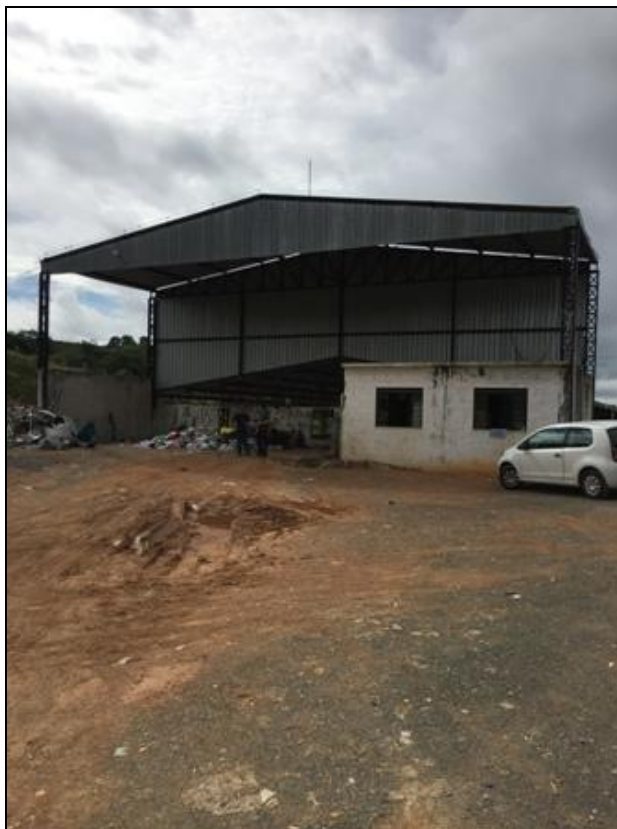
Figura 68 – Vista frontal do galpão de triagem
