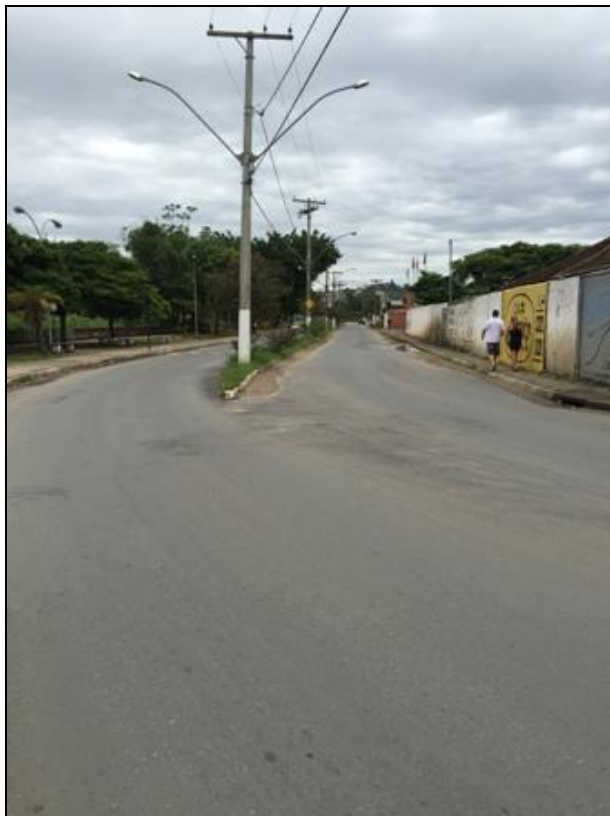
Figura 155 – Área Problema 6: região afetada pelo alagamento
